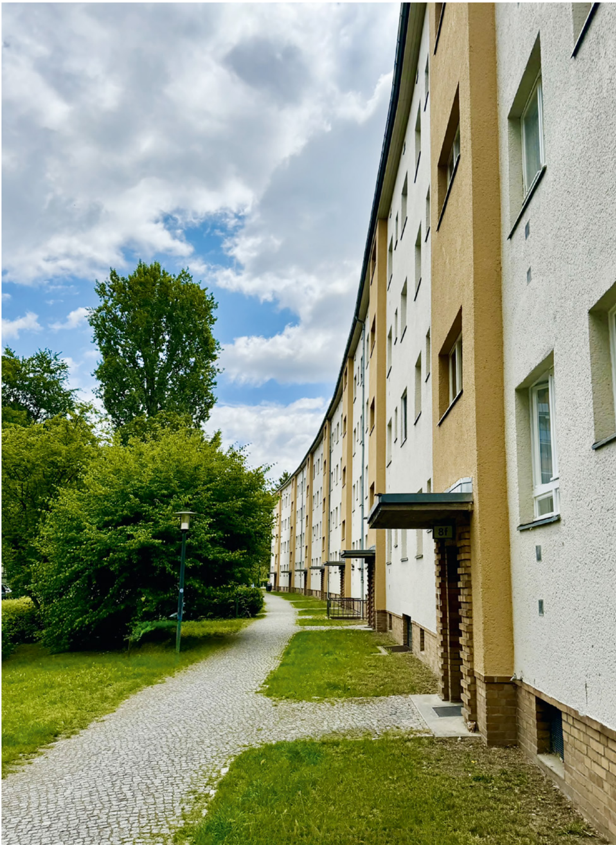
Neue Wohnanlage Haselhorst
