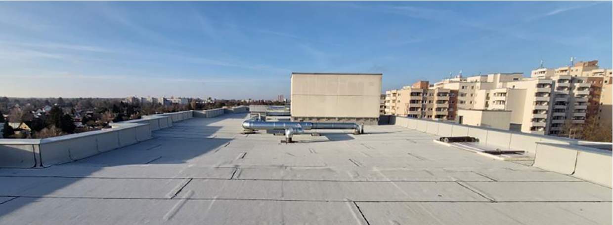
Dach in der Skarbinastr. 48 - 62
