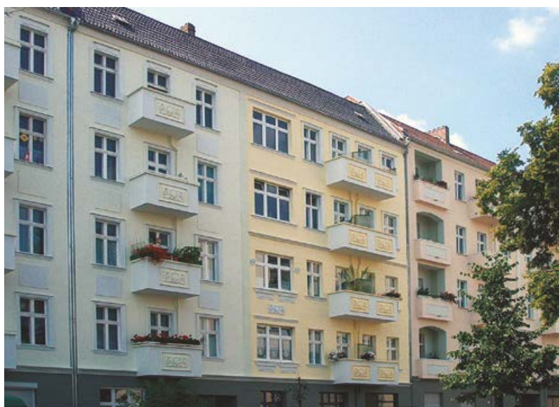
Hausgruppe in der Treptower Beermann- straße (Block 47/48)
