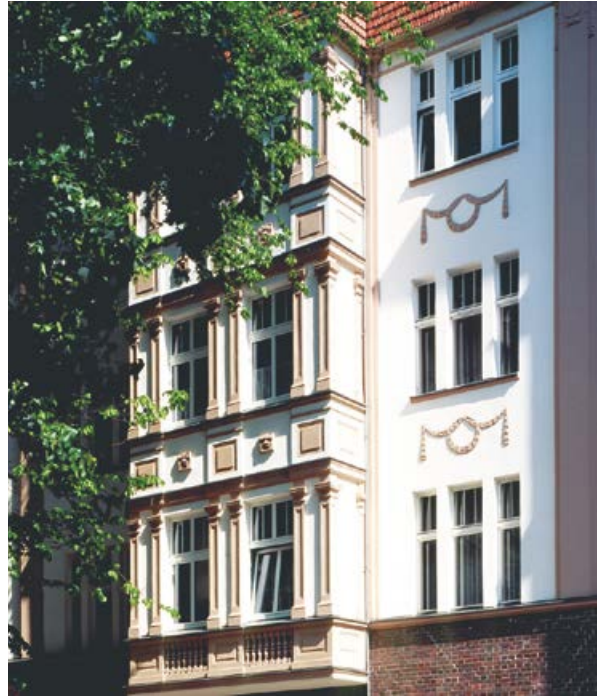
Fassade in der Fuldastraße
