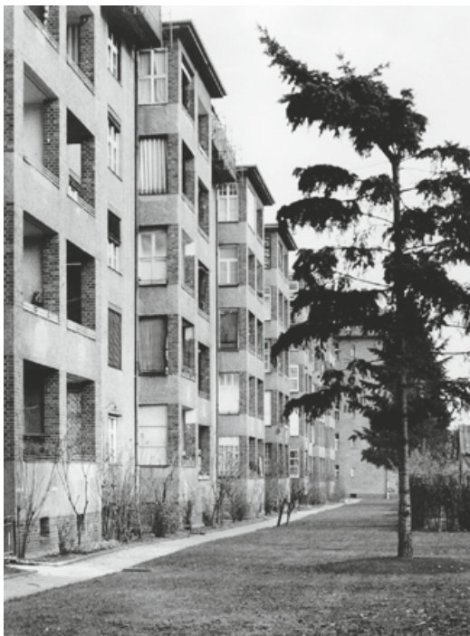
Wohnanlage Leykestraße mit Straßenfront und Gartenseite (Block 8)
