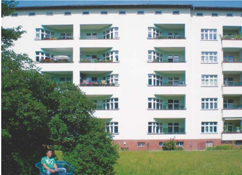
Hofansicht der 1927–28 errichteten Taut-Bauten in der Fuldastraße (Block 20)
