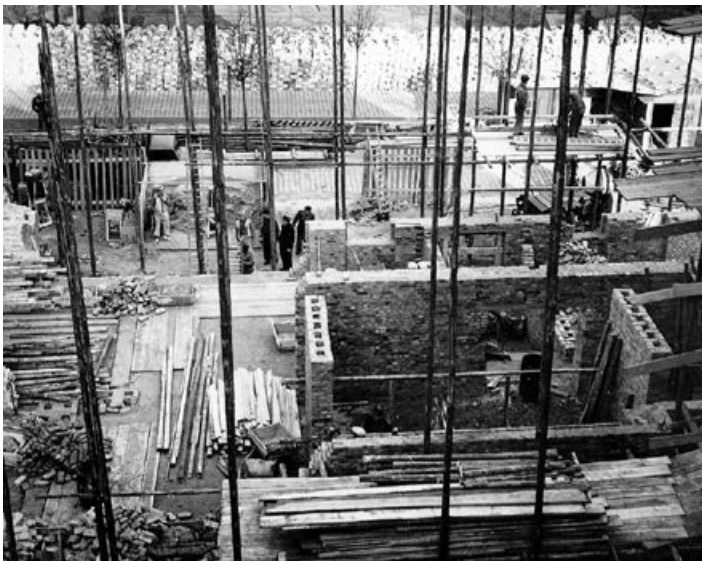
Blick auf die Baustelle in der Elbestraße 1954 (Block 21)
