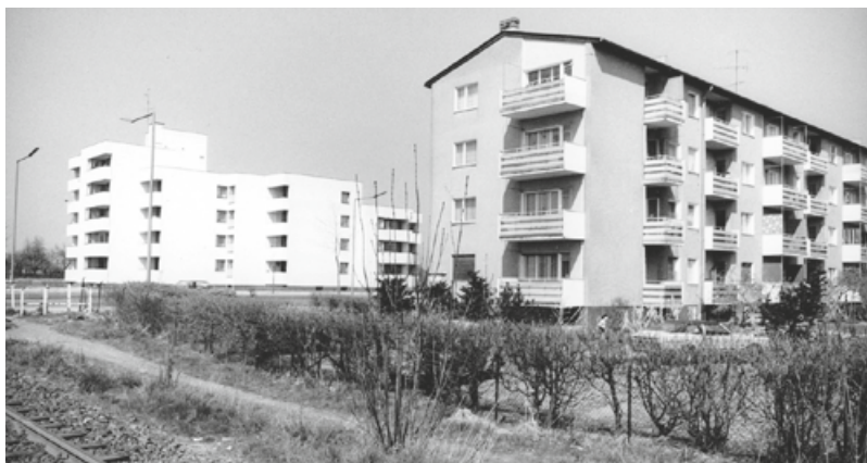
»Alt«- und Neubauten der Genossenschaft an der Johannisthaler Chaussee
