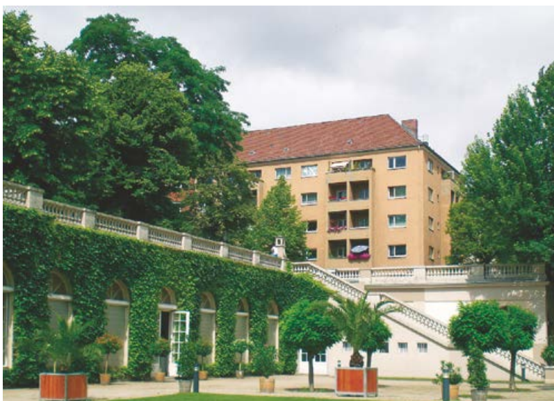
Blick vom tiefer gelegenen Körnerpark auf die Wohnanlage an der Selke- und Jonasstraße
