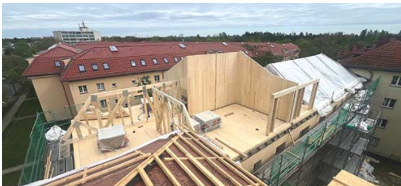
Dachgeschossausbau in Mariendorf, 2024
