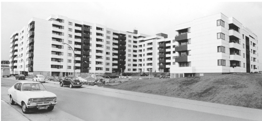
Neubau an der Aschaffener Straße (heute Skarbinastraße) in Lichtenrade
