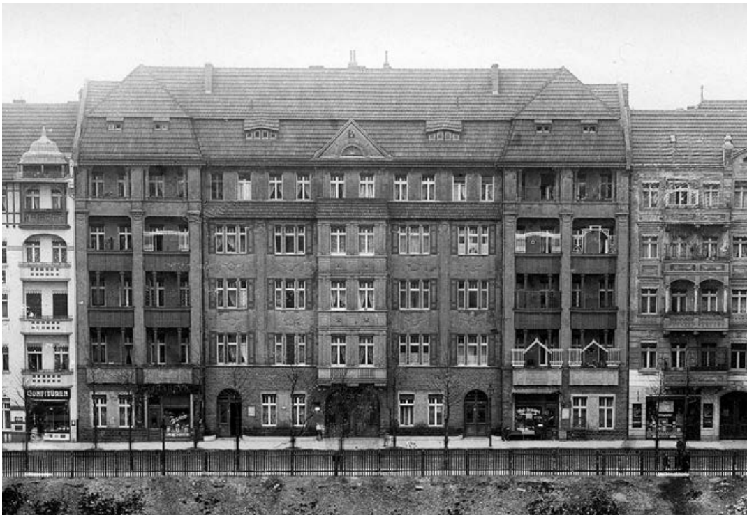
Fuldastraße 14/15 (Block 5), erbaut 1909
