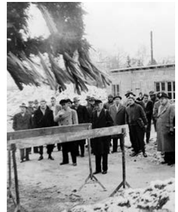
Richtfest des Projekts Johannisthaler Chaussee am 7.12.1959
