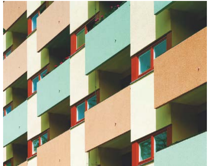
Detailansicht des Apartmenthauses »Bremen« im Mariendorfer Weg
