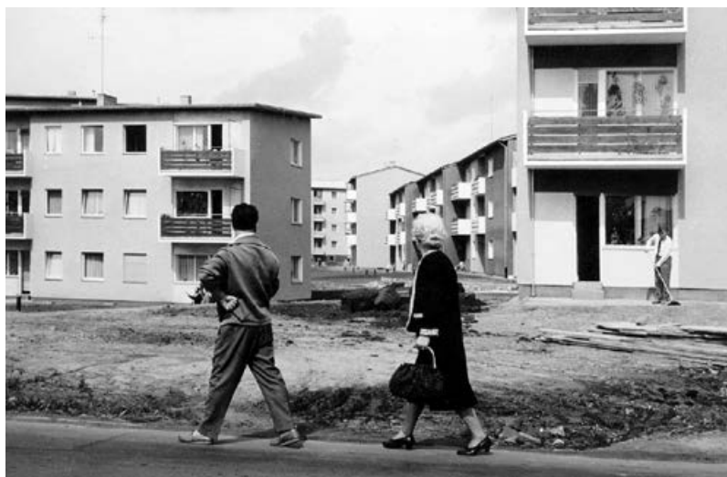
Begehung der Neubauten (Block 33 und 34) in Buckow
