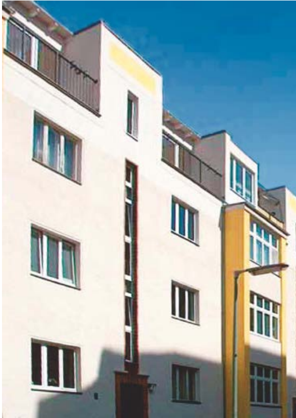
Dachausbauten in der Tejastraße
